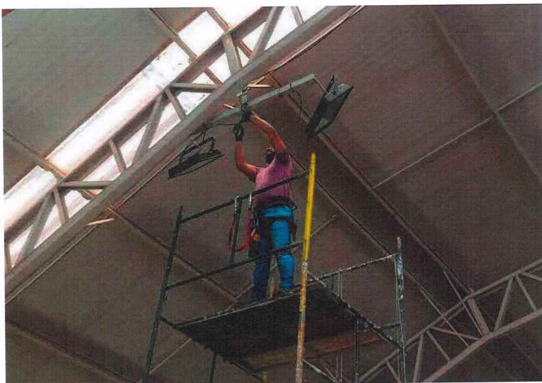
Instalação de Refletores
